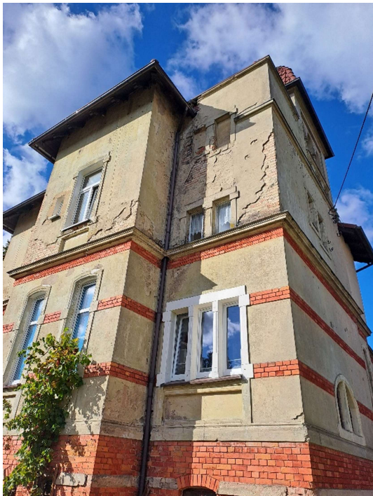
Zdj. nr 11 – widok zawilgoconych i odspojonych tynków elewacji wschodniej
