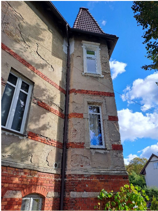
Zdj. nr 9 – widok uszkodzeń tynków i detali elewacyjnych
