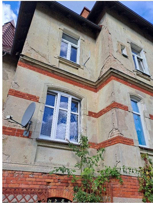
Zdj. nr 10 – widok uszkodzeń tynków
